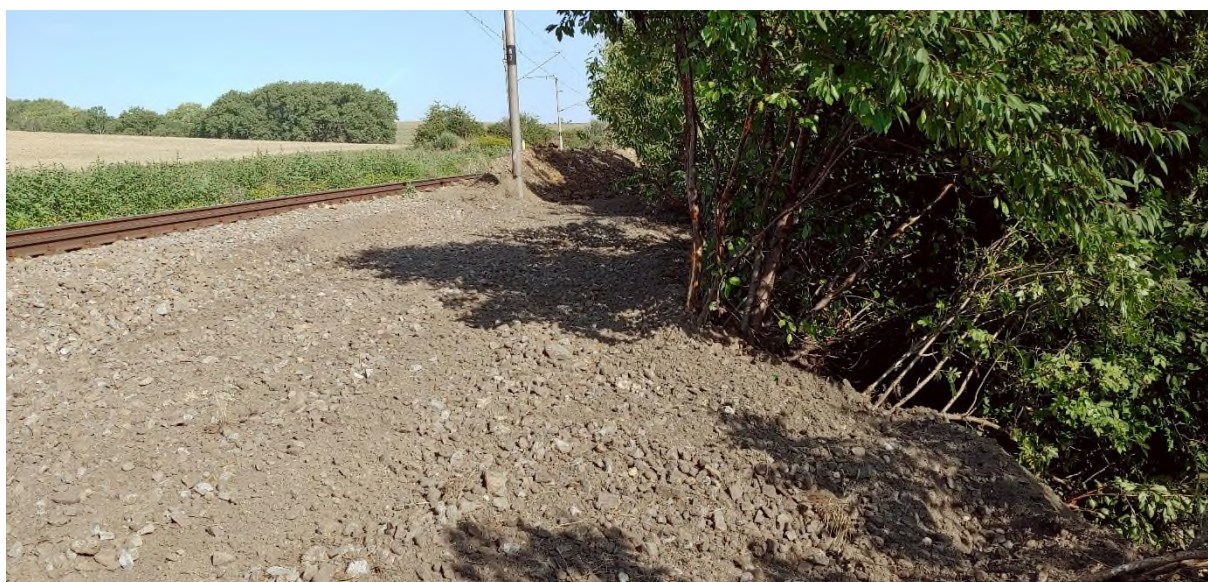
OBR.6 „NOVÝ“ PŘÍSYP K PRAVÉ HRANĚ NÁSYPOVÉHO TĚLESA...
