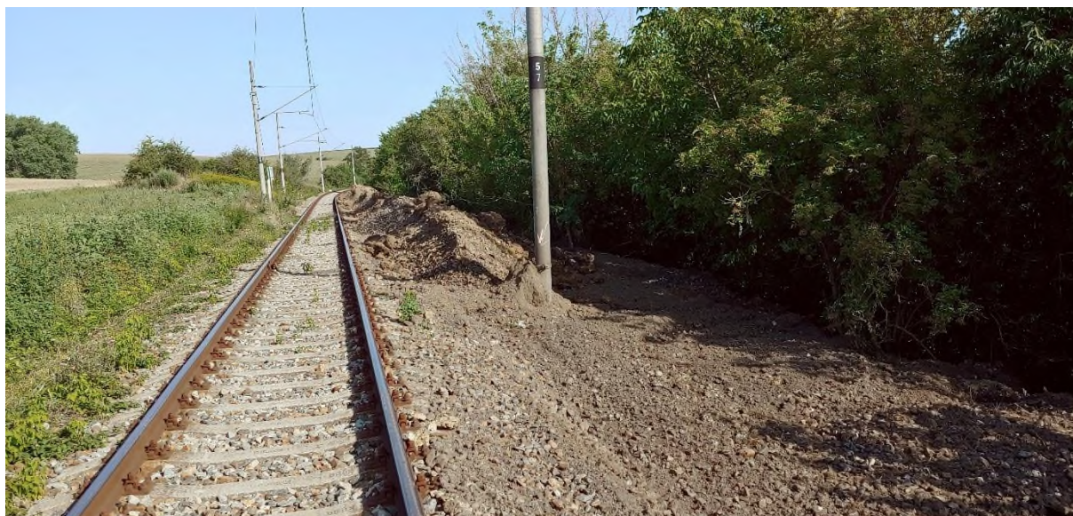
OBR.5 „NOVÝ“ PŘÍSYP K PRAVÉ HRANĚ NÁSYPOVÉHO TĚLESA BEZ PŘEDCHOZÍHO ODSTRANĚNÍ VEGETACE
