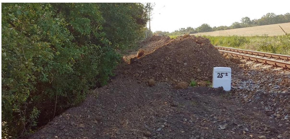
OBR.4 „NOVÝ“ PŘÍSYP K PRAVÉ HRANĚ NÁSYPOVÉHO TĚLESA BEZ PŘEDCHOZÍHO ODSTRANĚNÍ VEGETACE A ZŘEJMĚ I „ZAZUBENÍ“
